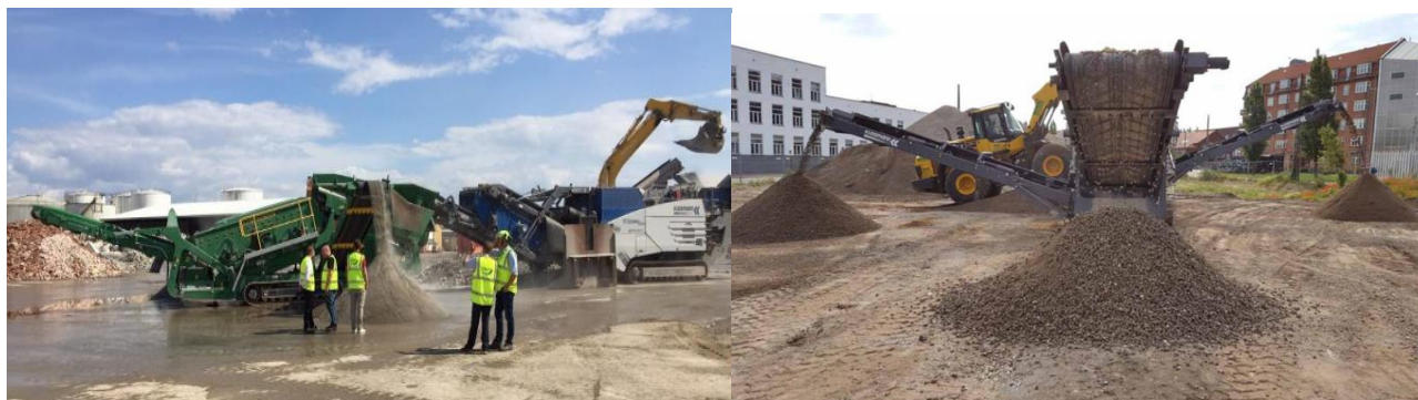
Figur 10: To typer af mobile knuseanlæg med separator anvendt til nedknusning af donorbeton.
