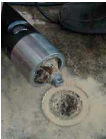
Figur 11. Lok-test (og Capo-test) laver en begrænset skade i betonens overflade. Skaden kan med lidt behændighed repareres, så det ligner et udsat clampshul.
