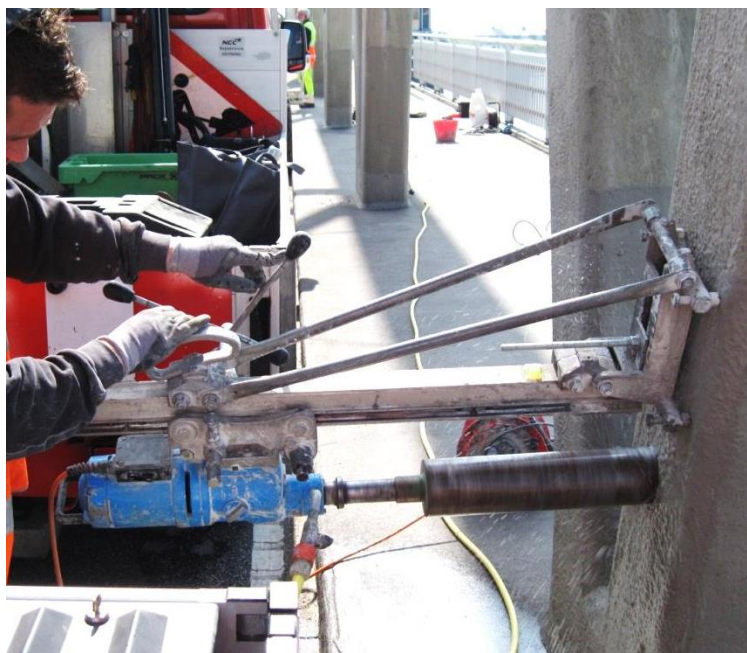
Figur 9. Vandret udboring af borekerne med diamantbor.
