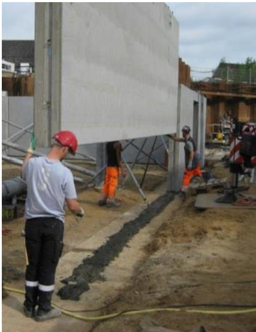
Figur 10. Understøbning af vægelement.
