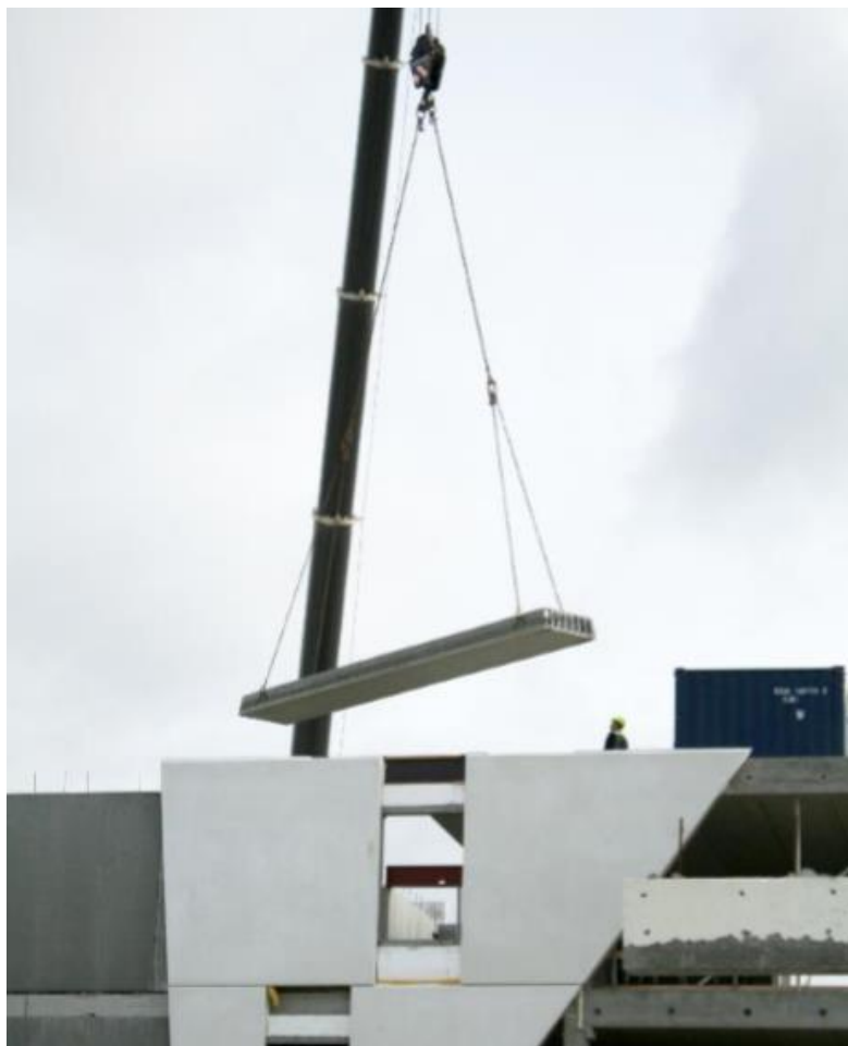
Figur 9. Elementmontage med mobilkran.
