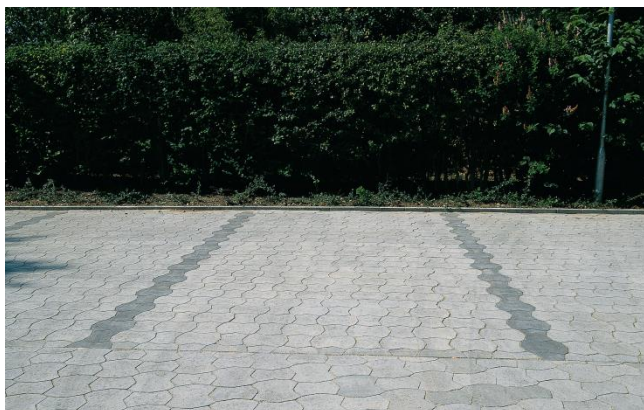
Figur 10. Afmærkning af parkeringsbåse ved hjælp af to forskellige stentyper og farver
