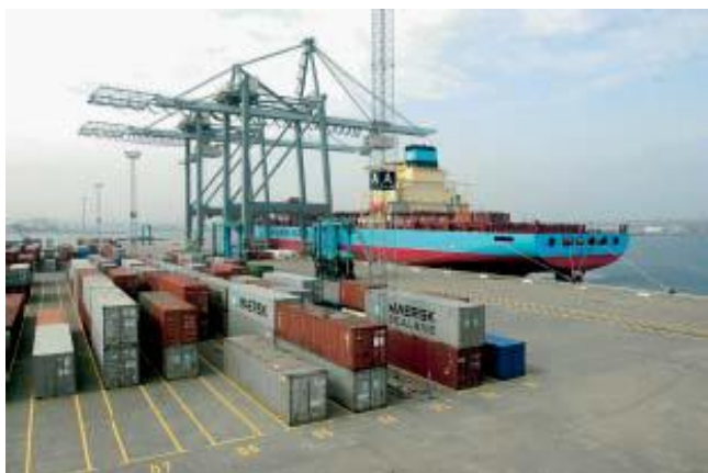
Figur 11. På containerpladser udnyttes betonstens tekniske egenskaber til fulde. (Containerhavnen i Århus, ca. 130.000 m 2 )
