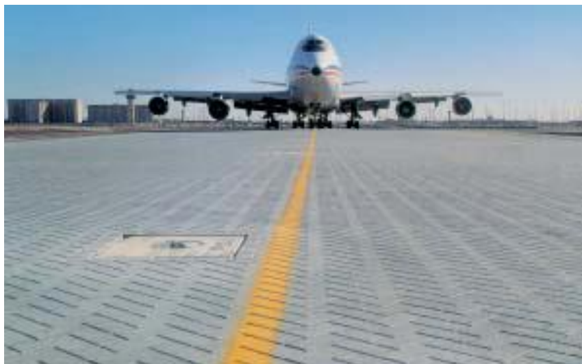
Figur 3. Betonsten og fliser anvendes meget bredt til alt fra fortove til lufthavne
