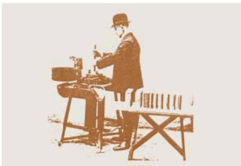
Figur 4. Billede fra 1920, hvor støbning af betonsten og -fliser var håndarbejde. Dette stillede store krav til den enkelte person, hvis kvaliteten skulle være god
