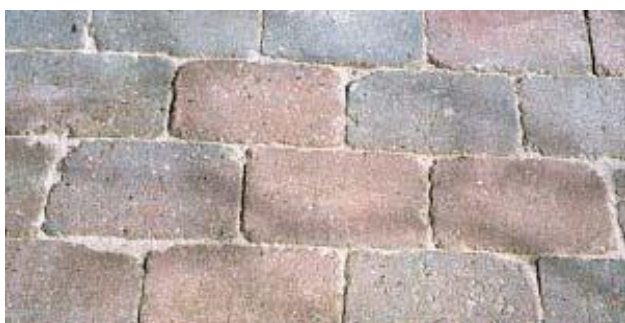
Figur 7. Et eksempel på efterbehandlede sten er betonsten med slåede kanter. Disse har et mere rustikt udseende
