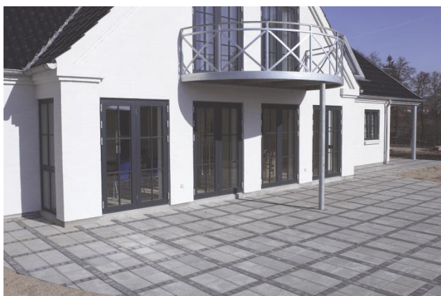
Figur 13 og 14. Betonsten er meget anvendt til terrasser og indkørsler, og ved det rette valg af farve og type, kan stenene passe til såvel nyt som gammelt byggeri
