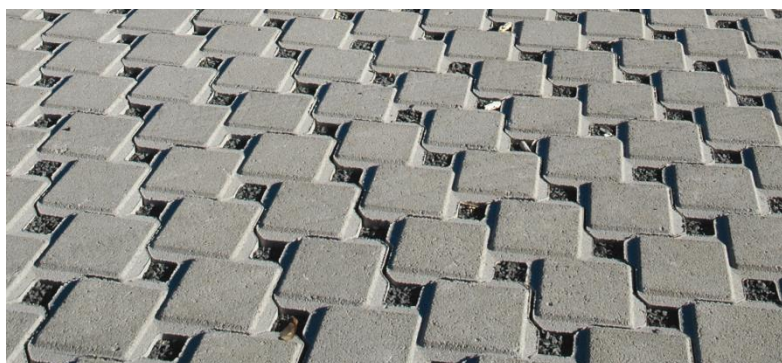
Figur 18. Parkeringsplads med permeabel belægning af betonsten
