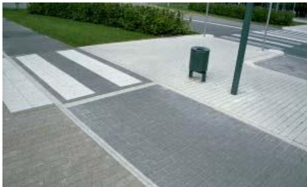
Figur 8. Eksempel på trafikregulering med betonsten i forskellige farver og varierende overflader (Allerød)
