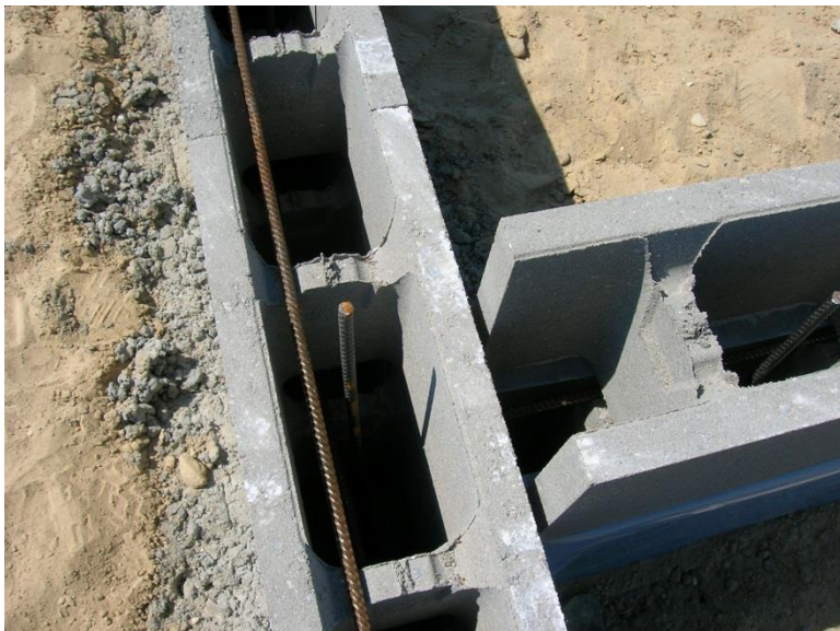
Figur 6. Placering af armering
