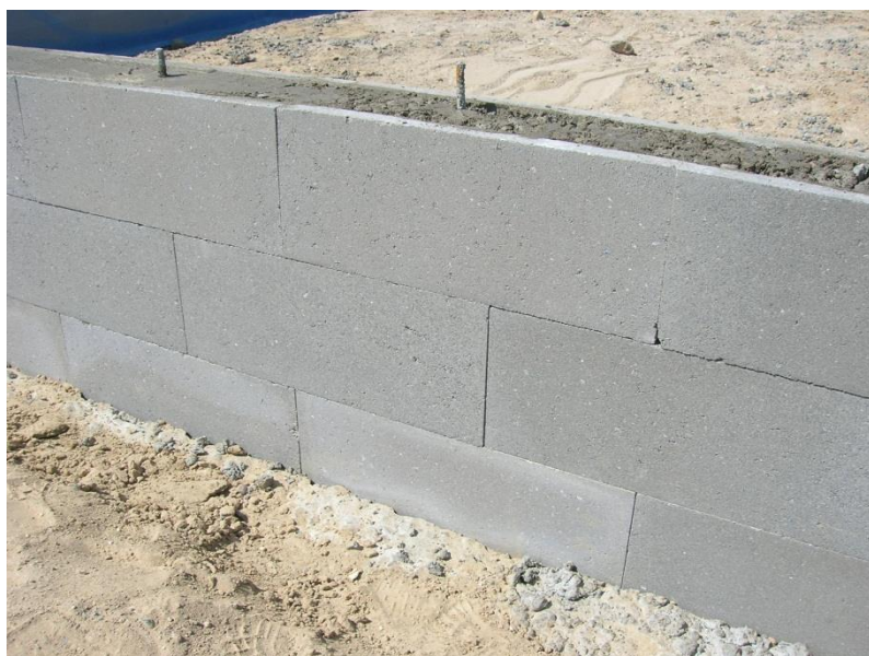
Figur 5. Udstøbningsblokke anvendt i fundament
