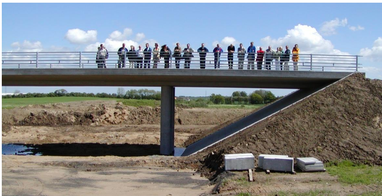
Figur 1. Denne bro er det første bygværk, der blev fremstillet med anvendelse af "Grøn Beton". Broen – Vejdirektoratets Bro 34 på Riis-Ølholm strækningen i Tørring er opført i 2002 - og siden udvidet i 2009 – også med grønne betoner. [2]
