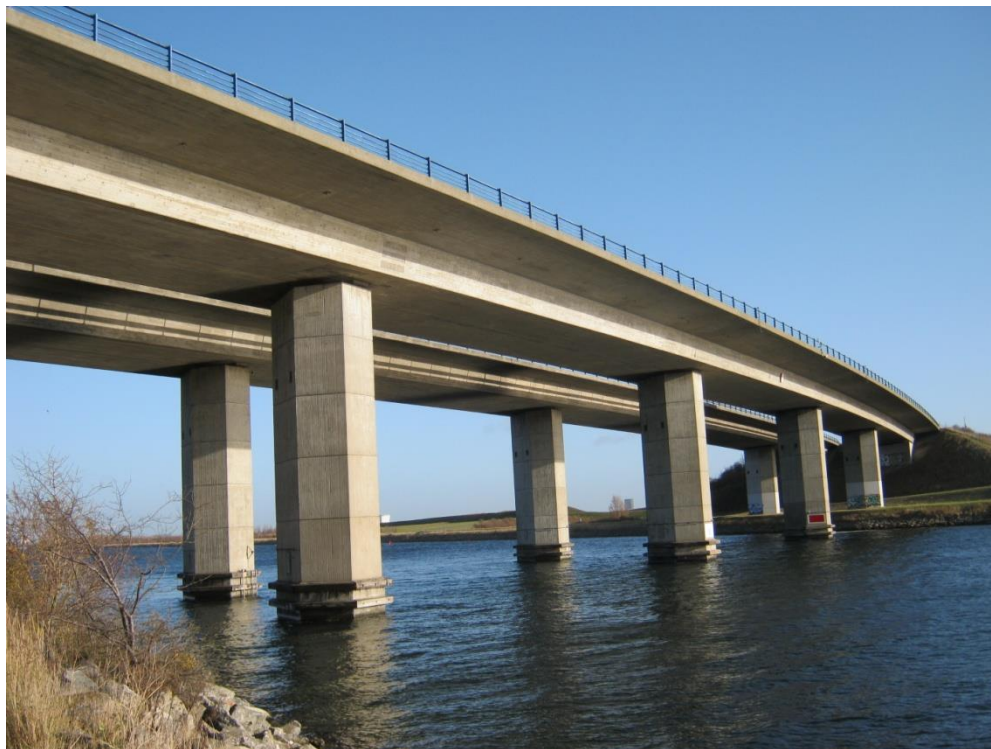
Figur 2. Overbygningen på Kalvebodbroen fra Vestamager til den kunstige ø blev allerede i 1983 udført med tilsætning af mikrosilica for at opnå en mere stabil beton – især stabilisering af luftindholdet til sikring af frostbestandighed
