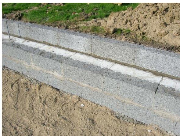
Figur 8. Fundament med letklinkerblokke
