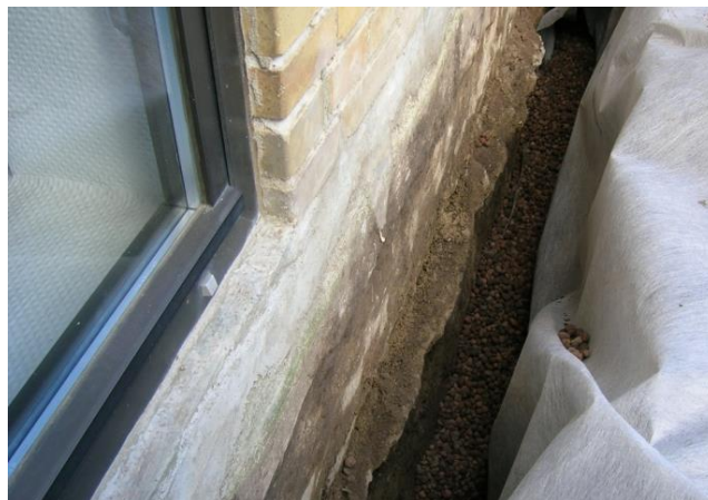
Figur 4. Efterisolering af kældervæg
