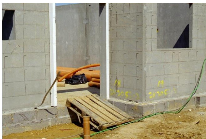
Figur 9. Helvægselementer af letklinkerbeton
