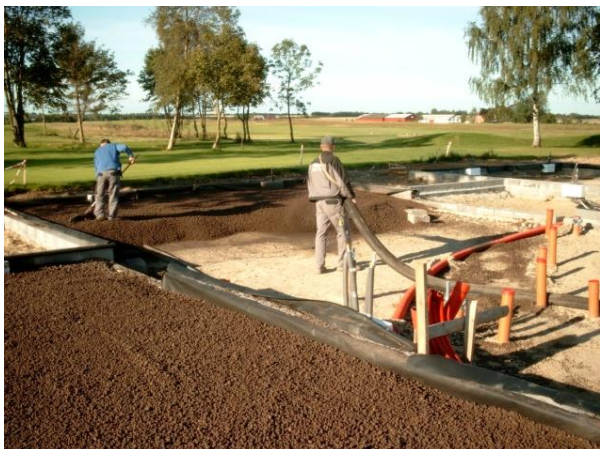
Figur 3. Isolering af terrændæk
