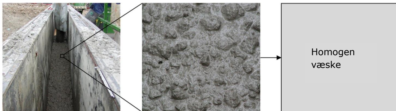
Figur 6. Vægstøbning med beton. Hvis betonen forbliver sammenhængende, kan vi antage, at betonen opfører sig som en homogen væske
