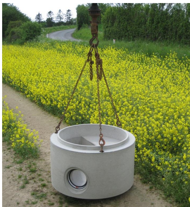
Figur 1 og 2. Ø 500 x 2250 mm rør og drejebrønd aflæst langs med kommende rørledning
