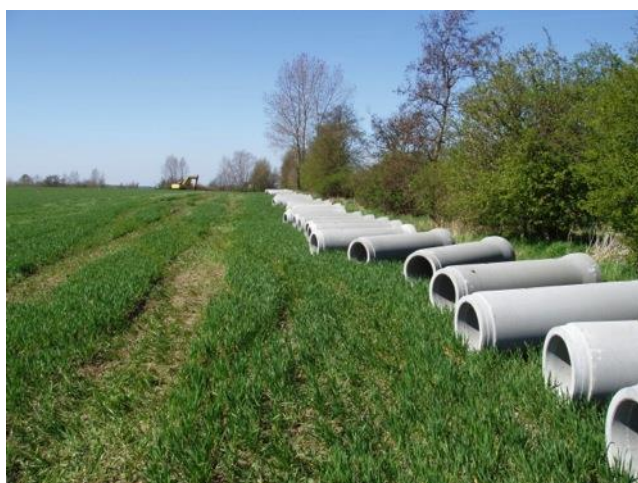
Figur 1 og 2. Ø 500 x 2250 mm rør og drejebrønd aflæst langs med kommende rørledning
