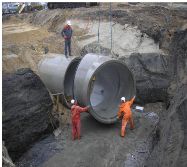
Figur 7. Ø 2250 mm rør
