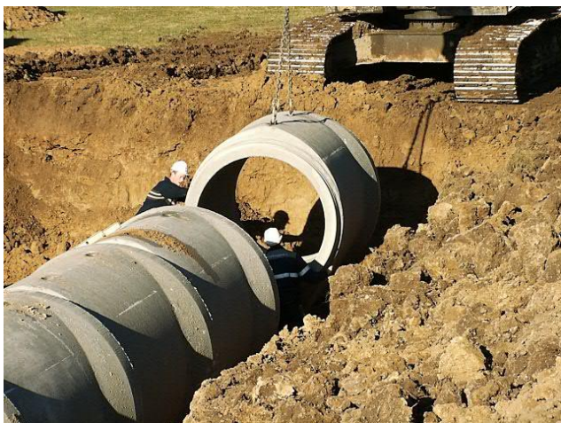
Figur 3. Lægning af Ø 1600 x 2225 mm rør
