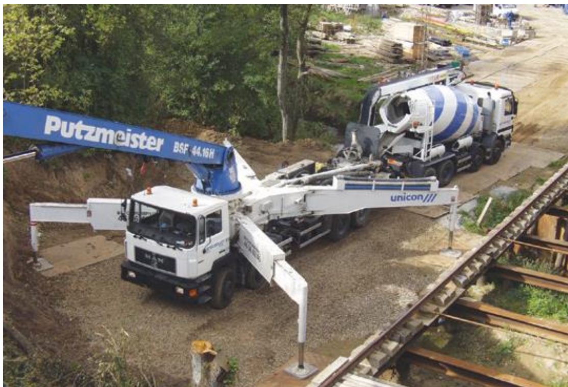
Figur 11. Eksempel på udfoldede støtteben på mastepumpe
