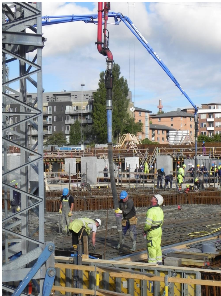
Figur 5. Pumper (på billedet to pumper) kan effektivt transportere betonen til steder, hvor adgangsforholdene er begrænsede
