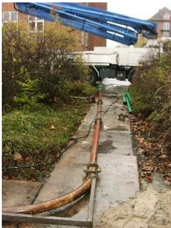
Figur 6. Hvor pumpen ikke kan komme tæt på støbestedet, kan udlænges forlængerrør
