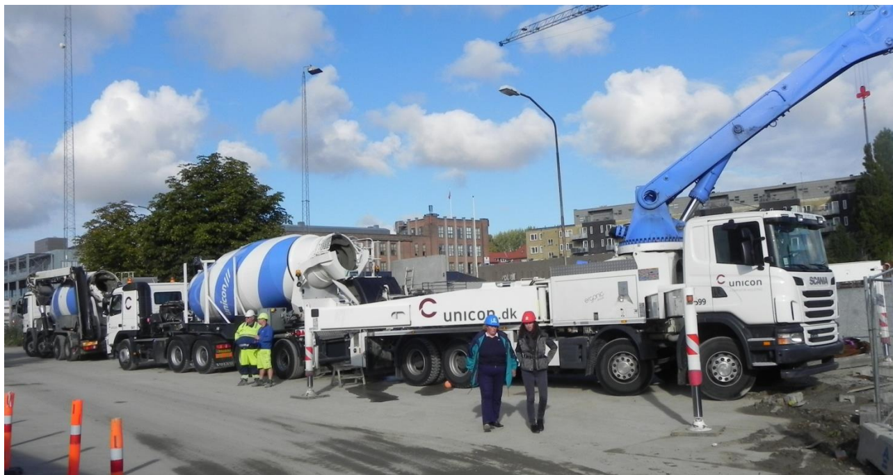
Figur 7. Pumpen forsynes fra roterbiler. Det kan være en fordel at have en bil i reserve, mens der læsses af. Herved kan pumpen levere en kontinuert mængde. Pumpen leverer beton til den blå pumpe på figur 5
