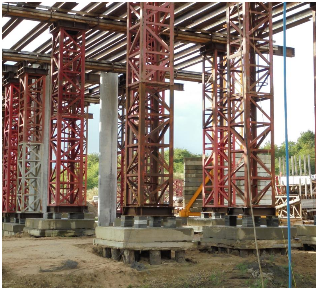
Figur 7. Ved dårlige funderingsforhold – billedet er fra Gubsø nord for Silkeborg, hvor forholdene var ekstremt dårlige – rammes ofte træpæle, hvorpå stilladset funderes. På billedet udgjordes stilladstårnene af til formålet opsvejste stålkonstruktioner.
