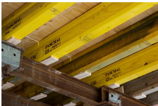
Figur 4. Til venstre: Finerplader som støbehud, Trædragere i henhold til EN 13377, som strøer, samt kiler. Til højre: Støbebrædder som støbehud og spær. Bemærk finerpladerne som vandret afstivning af spærerne for at forhindre spærerne i at vælte.
