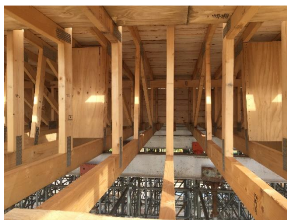
Figur 4. Til venstre: Finerplader som støbehud, Trædragere i henhold til EN 13377, som strøer, samt kiler. Til højre: Støbebrædder som støbehud og spær. Bemærk finerpladerne som vandret afstivning af spærerne for at forhindre spærerne i at vælte.
