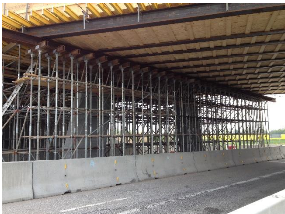
Figur 6. HEB bjælker anvendt som ridedragere over vej. Pga. at stilladset ikke er placeret vinkelret på spærerne, er der anvendt dobbelt lag ridedragere for at sikre, at spærerne understøttes i de korrekte understøtningspunkter.
