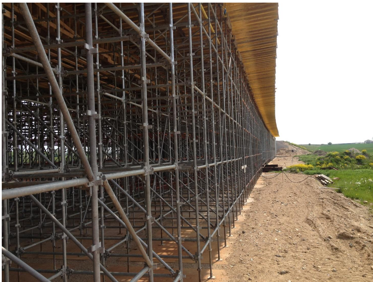
Figur 1. Formbærende systemstillads til støbning af bro på Holbæk-Vig motortrafikvejen 2012. Stilladset er funderet på stålplader udlagt på en gruspude.
