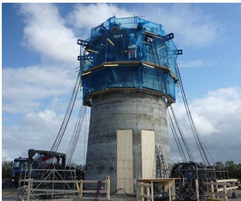
Figur 8. Glideforskalling på vindmølleårn, Lemvig. Klatreforskalling til trappetårn, Amagerforbrænding. Bemærk de to karakteristiske overflader, der følger af fremgangsmåden.
