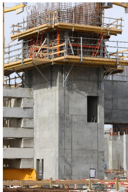
Figur 8. Glideforskalling på vindmølleårn, Lemvig. Klatreforskalling til trappetårn, Amagerforbrænding. Bemærk de to karakteristiske overflader, der følger af fremgangsmåden.
