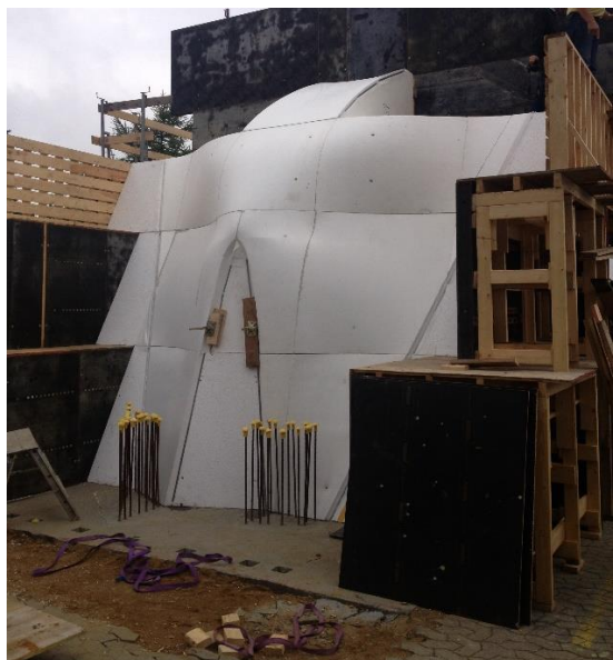
Figur 10. Specialforskalling brugt i kombination med træudsparinger og systemforskalling som lastbærende.
