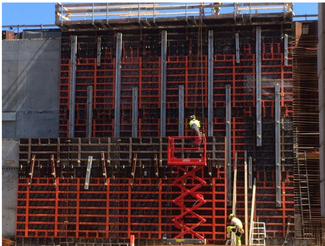
Figur 6. Vægforskalling i flere højder.
