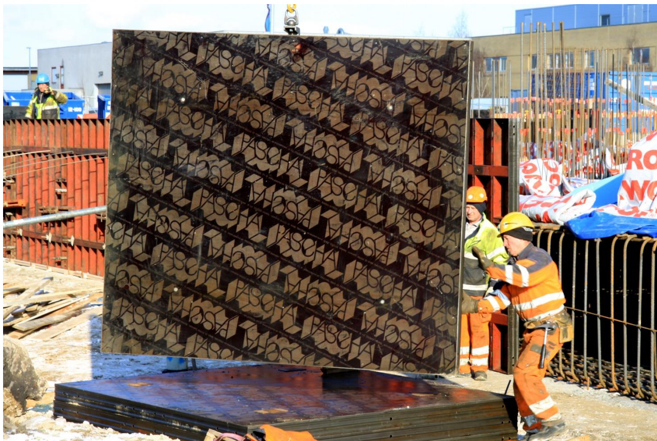
Figur 1. Systemforskalling med glat forskallingsplade.
