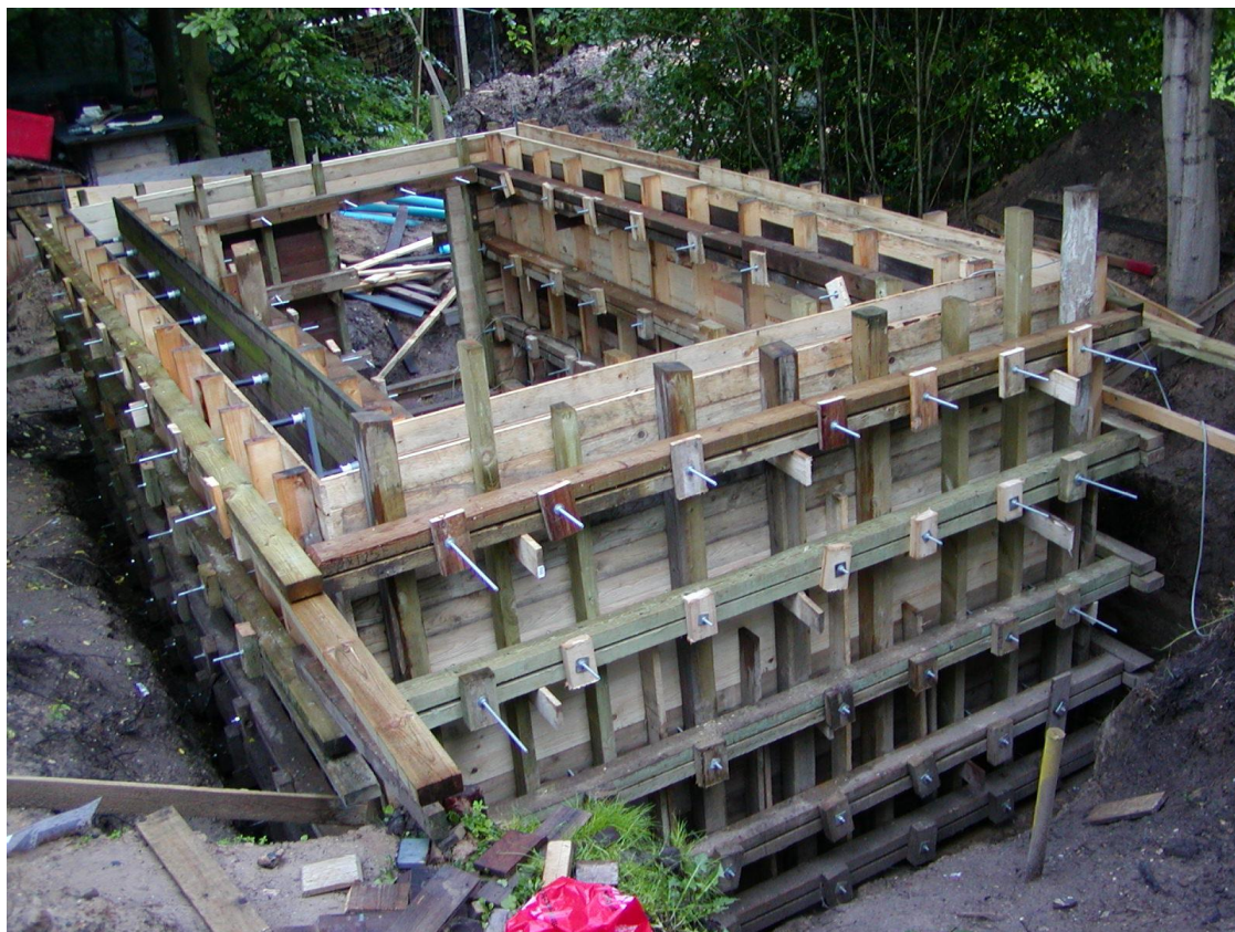
Figur 3. Traditionel forskalling til en jordkælder er opbygget i træ af en gør-det-selv mand. Her er som klamsjern brugt gevindstænger.
