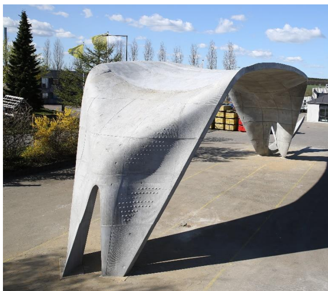
Figur 10. Specialforskalling brugt i kombination med træudsparinger og systemforskalling som lastbærende.
