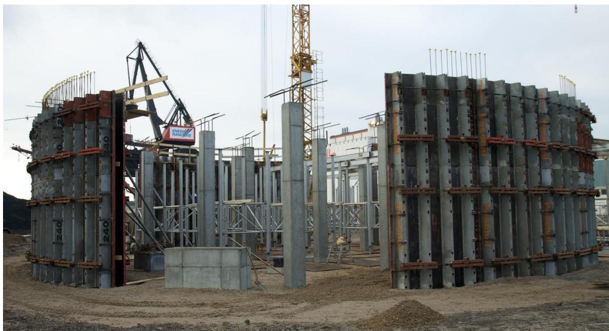
Figur 9. Systemforskalling til udførelse af runde vægge.
