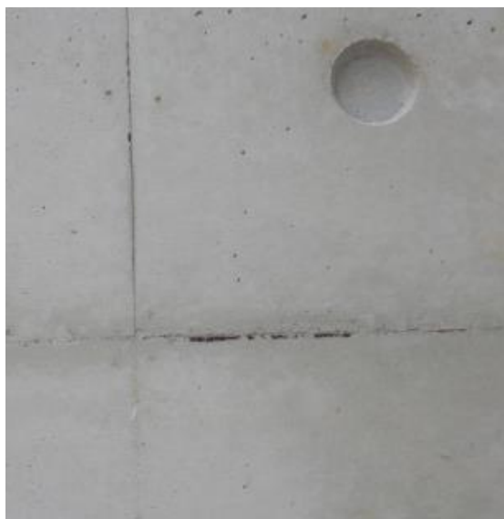
Figur 2. I kapitel 1.3 Arkitektur er mange figurer med forskellige betonoverflader. Overfladen til venstre er opnået med traditionel bræddeforskalling, se kapitel 1.3, figur 26 (Sælarium – udvidelse af Nordsømuseum i Hirtshals fra 2001 af Friis & Moltke), mens overfladen til højre er opnået med støbeplader, se kapitel 1.3, figur 27 (Bunkermuseet i Hanstholm fra 2002 af CUBO Arkitekter).
