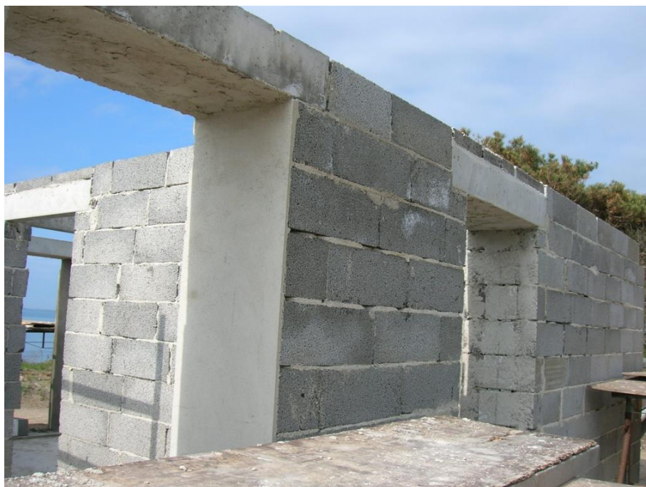
Figur 1. Letklinkerblokke i ydervægge og skillevægge
