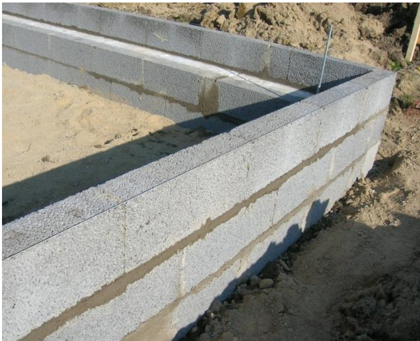
Figur 8. Fundament med minimalt linjetab
