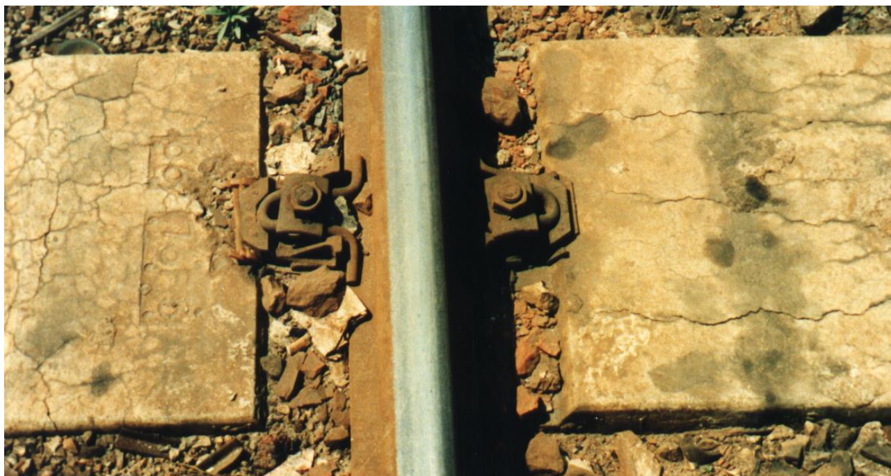
Figur 1. Sulfatnedbrydning i form af forsinket ettringit-dannelse i varmehærdede jernbanesveller. De på billedet viste sveller er produceret i Kina og tilsvarende skader er set på sveller i fx USA og Sverige.
