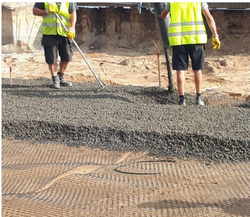
Figur 15. Udlægning af drænbeton.
