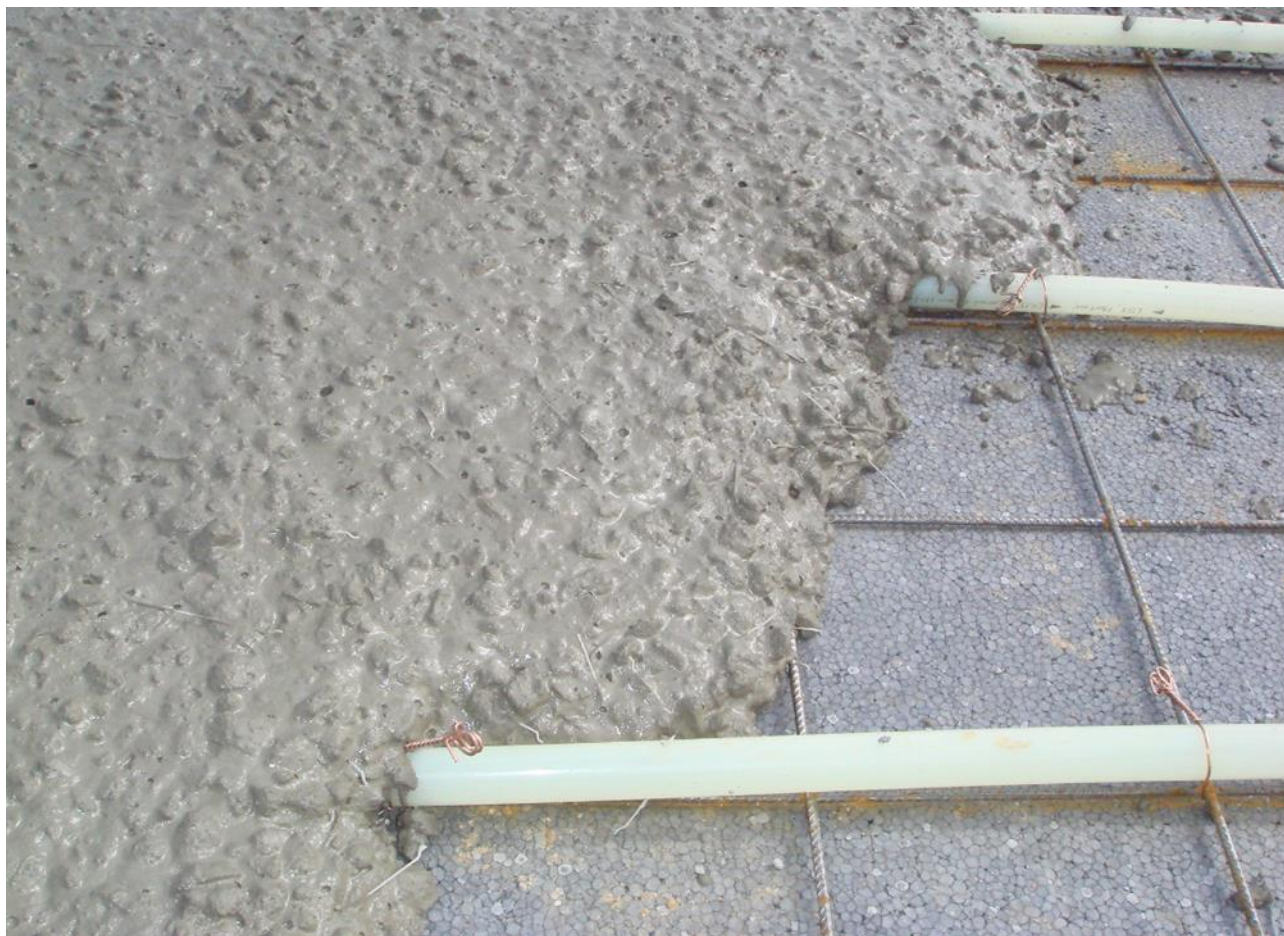
Figur 18. Stålfiberarmeret beton til gulv i et parcelhus.
