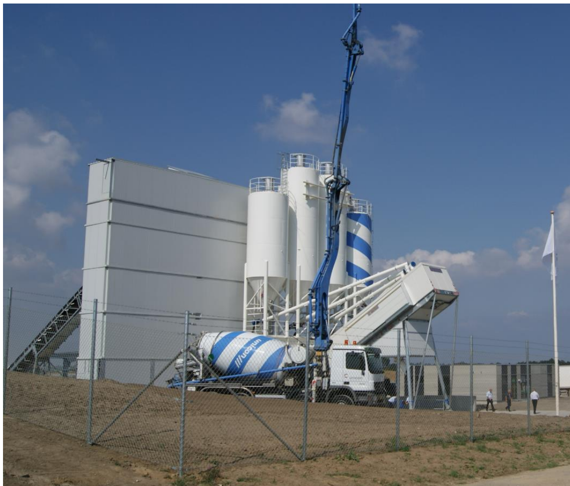
Figur 1. En typisk betonfabrik. Den på billedet viste er opført i 2013 i Sønderborg.
