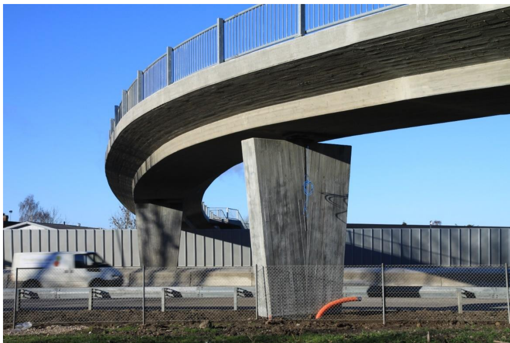
Figur 2. Stibro over Motorring 3 ved Hvidsværmervej i Rødovre. Opført i fabriksbeton med bræddeforskalling i 2009/2010. Foto af Michael Støvelbæk.
