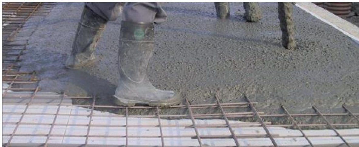
Figur 11. Udstøbning af SCC-beton til gulv i et parcelhus.
