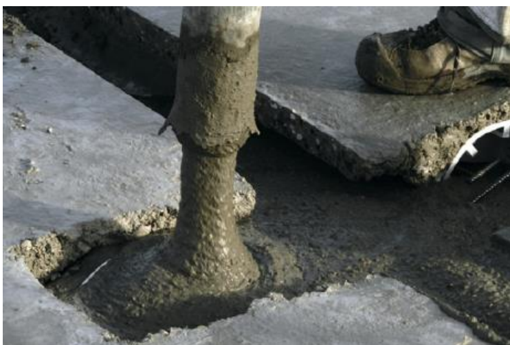
Figur 9. Sammenstøbning af fuger mellem huldækelementer.
