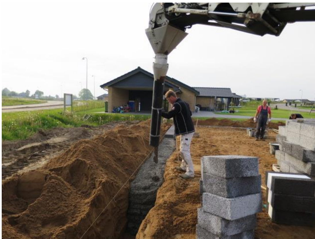
Figur 19. Støbning af et sribefundament med en færdigarmert fiberbetonløsning.
