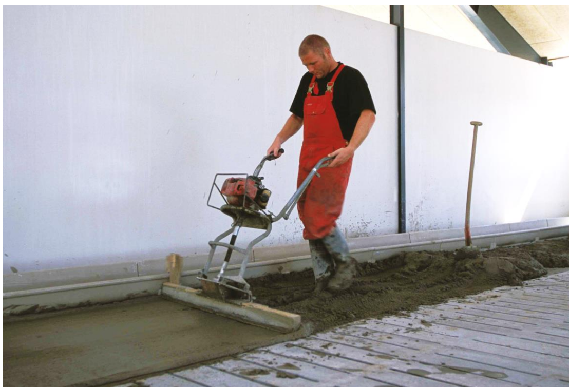
Figur 13. Udlægning og komprimering af slidlagsbeton.
