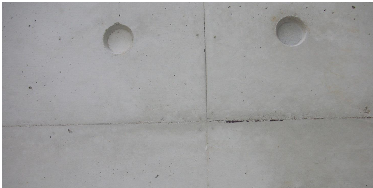
Figur 27. Betonoverflade støbt mod traditionelle støbeplader. Samlingerne mellem støbepladerne i forskallingen tegner en karakteristisk grat i betonen. Fra Bunkermuseet i Hanstholm fra 2002 af CUBO Arkitekter.
