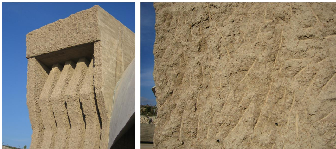
Figur 32. Eksempel på kløvede betonoverflader i forbindelse med MAGMA Kunst- og Kongrescenter på Tenerife fra 2005 af Fernando Martin Menis.
