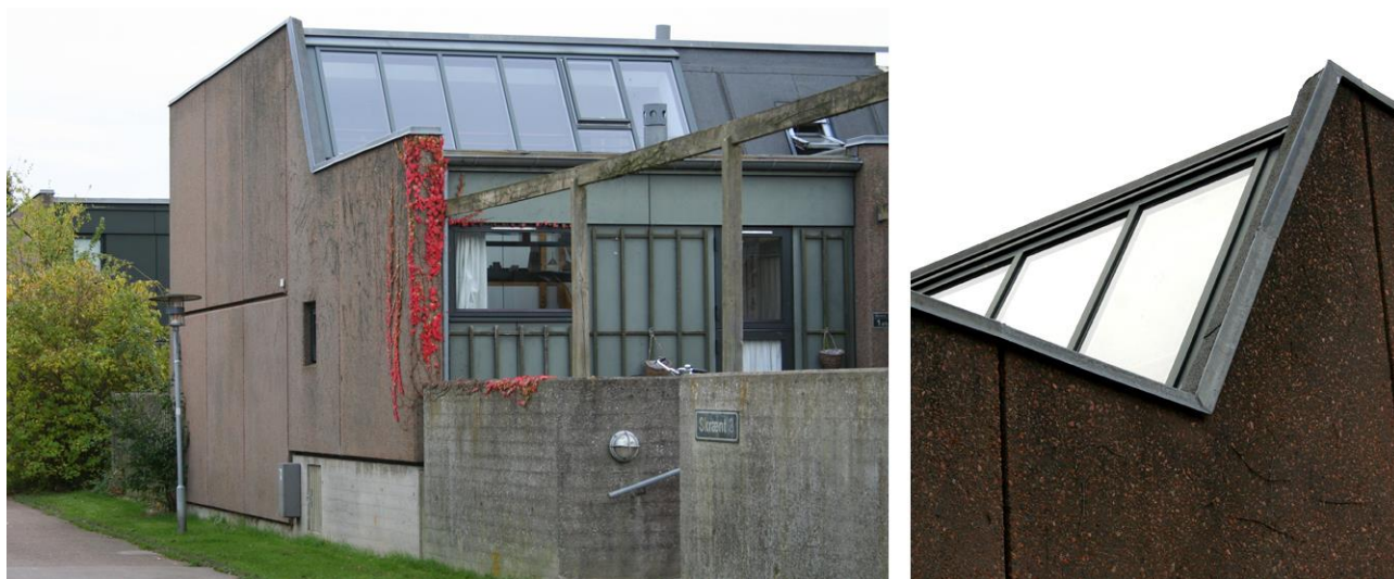
Figur 15. Galgebakken fra 1974 af J.P.Storgård & J. Ørum-Nielsen, Hanne Marchussen og Anne Ørum-Nielsen. De rødlige betonelementer med fritlagte overflader udgør et væsentligt udtryk i arkitekturen.
