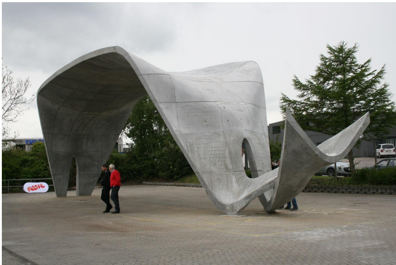
Figur 25. Betonpavillon i Aarhus der viser nogle af de formmæssige potentialer ved digital fabrikation af støbeforme til beton.
