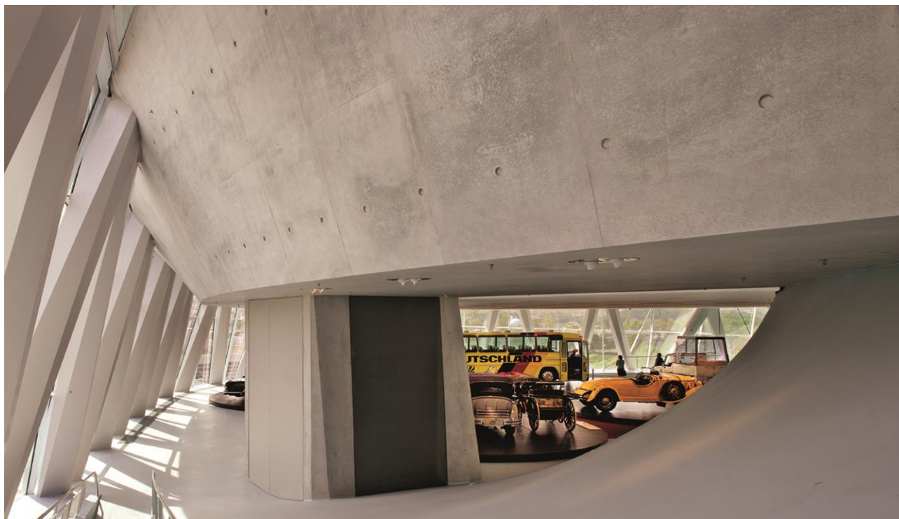
Figur 24. Dobbeltkrumme betonkonstruktioner i Mercedes Benz Museum i Stuttgart fra 2006 skabt via digitalt fabrikation af forskalling til beton.
