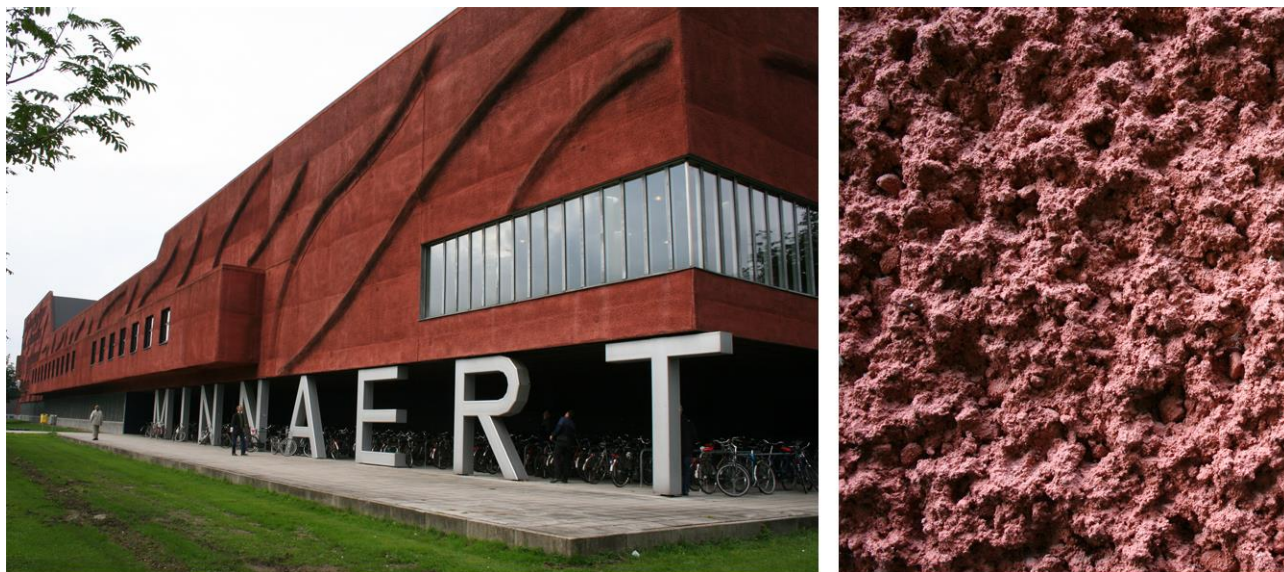
Figur 29. Sprøjtestøbte betonoverflader på Minnaert Building i Utrecht, Holland fra 1997 af Neutelings Riedijk.
