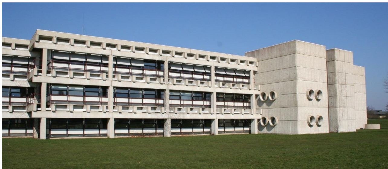
Figur 17. Roskilde Rådhus af Knud Munk. Fantasifuld sammenstilling af betonelementer.
