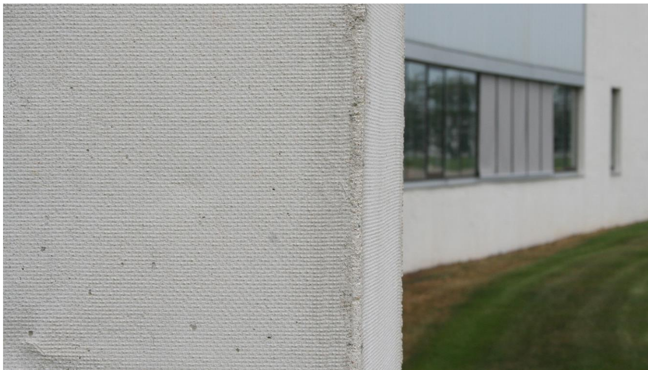
Figur 28. Tekstiler blev anvendt som forskalling i forbindelse med HEART i Herning fra 2009 af Steven Holl. Tekstilerne blev anvendt som indlæg i forskallingen, og har skabt særlig en særlig "stoflig" tekstur – inklusive foldninger i stoffet.
