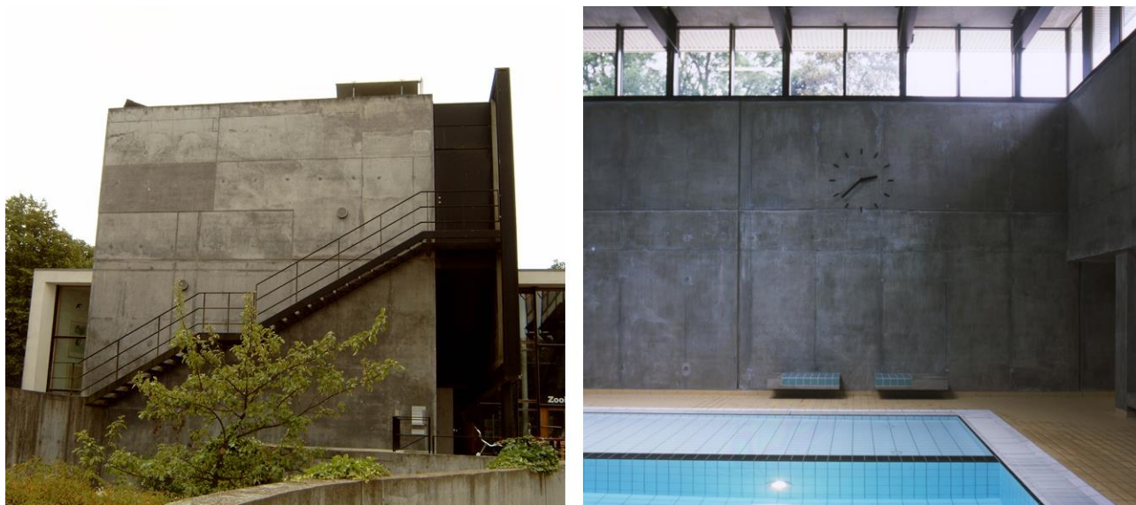
Figur 22. Tegnestuen Entasis fornyer den danske betonarkitektur, blandt andet gennem Indgangspartiet til Zoo i København fra 1998 (Tv) og Tilbygningen til Kildeskovshallen i Gentofte fra 2002 (Th).
