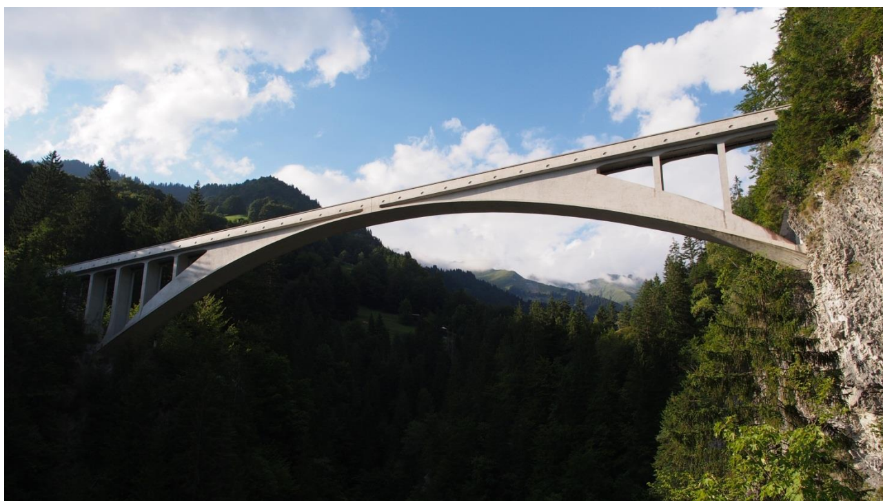
Figur 7. Elegant udformning af brokonstruktion i form af Salginatobelbrücke i Schweiz.
