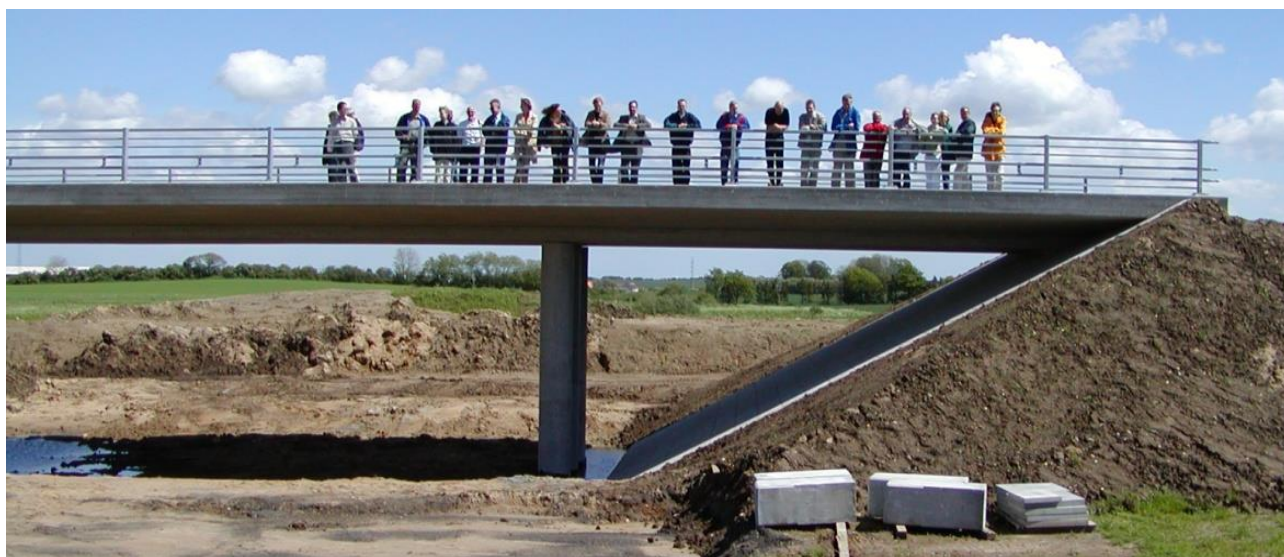
Figur 1. Denne bro er det første bygværk, der blev fremstillet med anvendelse af "Grøn Beton". Broen – Vejdirektoratets Bro 34 på Riis-Ølholm strækningen i Tørring - er opført i 2002 og siden udvidet i 2009 – også med grønne betoner. [1]
