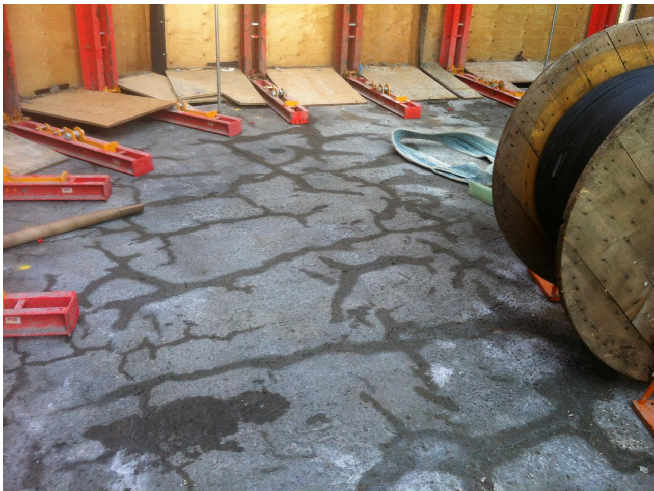
Figur 3. Plastiske svindrevner (udtørringssvind) i etagehusdæk. Specifikationerne foreskrev i dette tilfælde en meget cementrig beton, hvilket betød, at normale forholdsregler mod udtørringssvind ikke var tilstrækkelige. Tidligere etablering af udtørningsbeskyttelse og/eller etablering af vindafskærmning kunne her have afhjulpet problemet.
