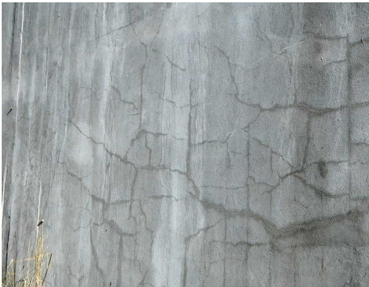
Figur 21. Revner forårsaget af alkaliskreaktioner i endevederlag til bro. De mørke randzoner omkring revnerne er et typisk kendetegn for revner forårsaget af alkaliskreaktioner.
