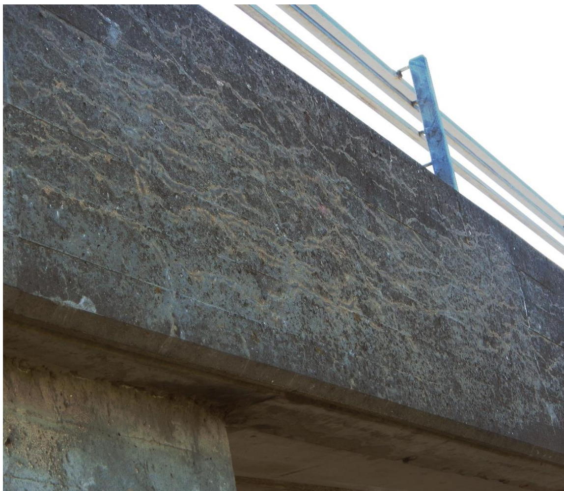
Figur 19. Udsivende alkalikisel-gel på kantbjælke af vejbro.
