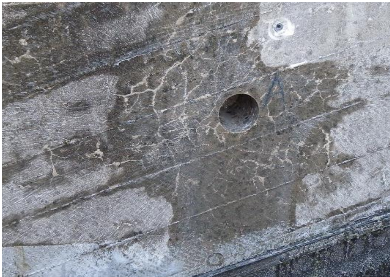
Figur 20. Udsivende alkaliskisel-gel i bjælke til tagudhæng.
