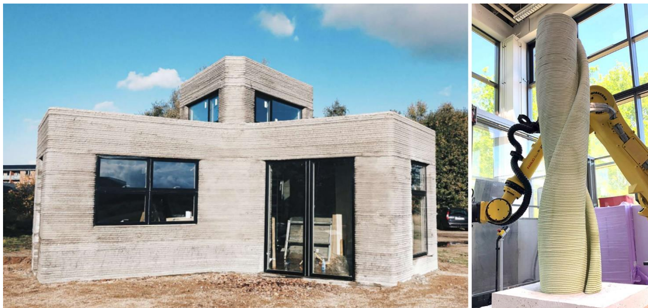
Figur 11: To danske eksempler på printede vægge/facader og søjler. Til venstre: 3D-printet betonhus i Holstebro af virksomheden 3DCP (Foto: 3DCP Group). Til højre: Organisk udformet søjle 3D-printet på Teknologisk Institut.
