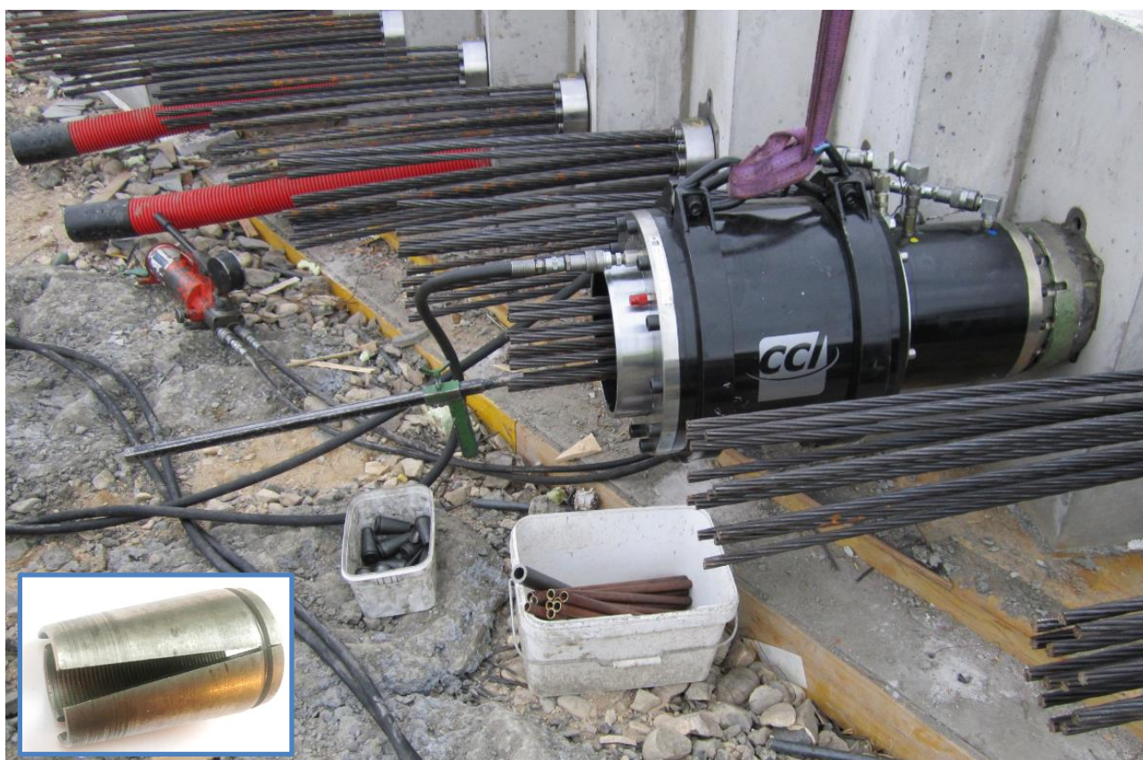
Figur 12. Liner klar til opspænding med den hydrauliske donkraft. De tredelte låse-kiler i æsken til venstre (op på det indsatte billede nederst til venstre) fastholder den enkelte line. Forankringerne er indstøbt i betonen til højre.
