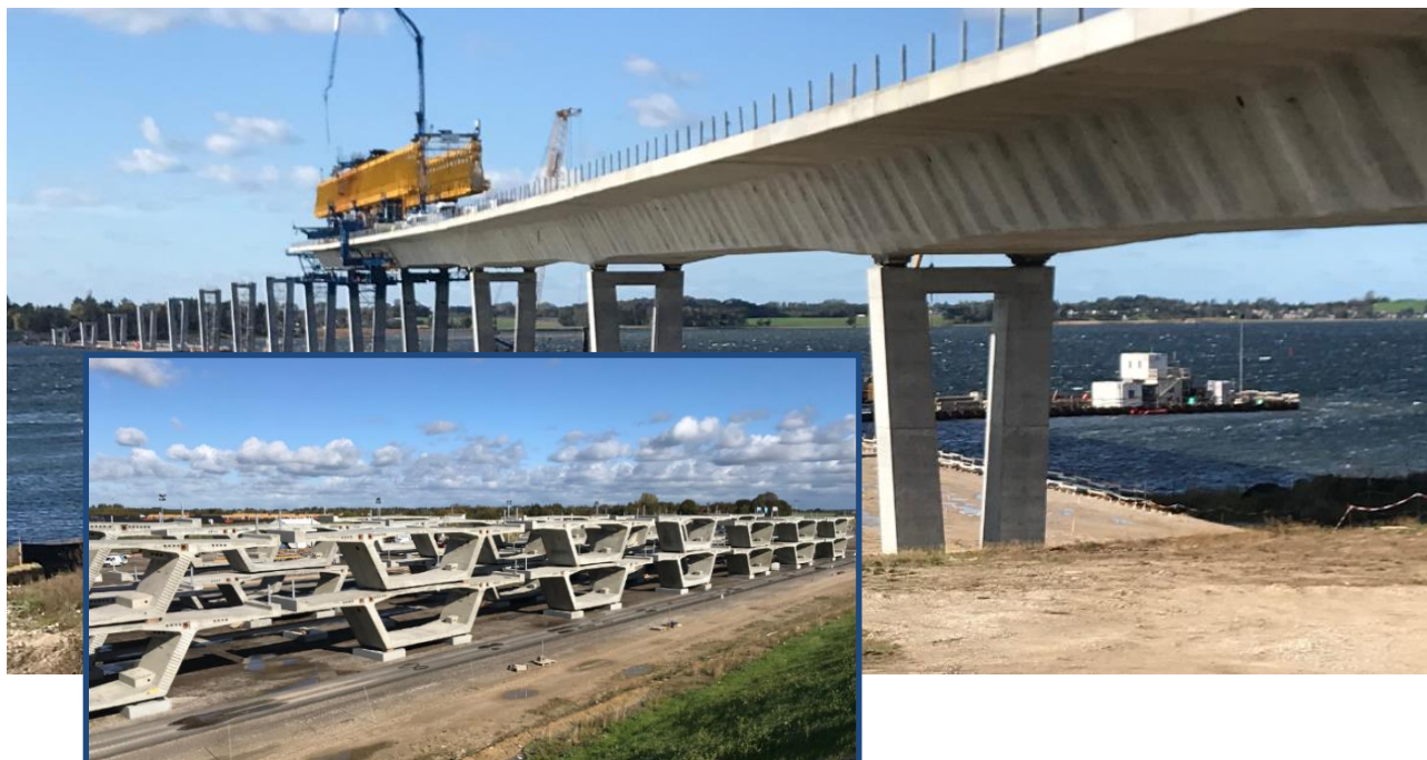
Figur 9. Prinsesse Mary's bro syd fra Frederikssund er bygget med elementer i fuldt brotværnsnit, sammenlimet og sammenspændt med spændarmering. I hvert element er indstøbt kabelrør, som linerne kan placeres i.
