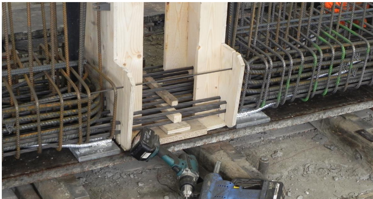
Figur 6. På en elementfabrik støbes en række forspændte bjælker, hvor formene er opstillet på række og linerne er opspændt gennem alle bjælkerne. På billedet ses to bjælkeender. Efter betonen har opnået tilstrækkelig styrke afskæres linerne ved bjælkeendernes overflade.
