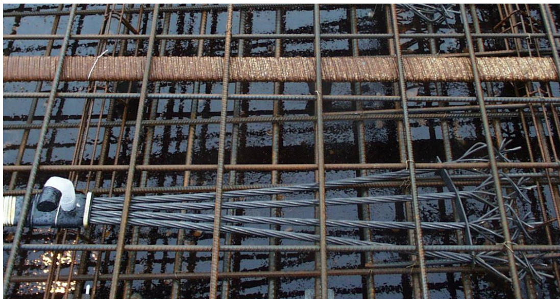
Figur 11. På Øresundsbroen blev dækket tværforspændt med et system af 4 liner i flade kabelrør. Nederst i billedet ses en passiv forankring, hvor linen splittes op og faststøbes i betonen – der opspændes fra venstre side. Linerne i kabelrøret øverst i billedet spændes fra højre side. Bemærk plastrøret til mørtel-injicering til venstre på det nederste kabelrør.
