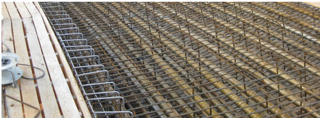
Figur 8. Kabelrørene er ilagt på en bro, der skal efterspændes.
