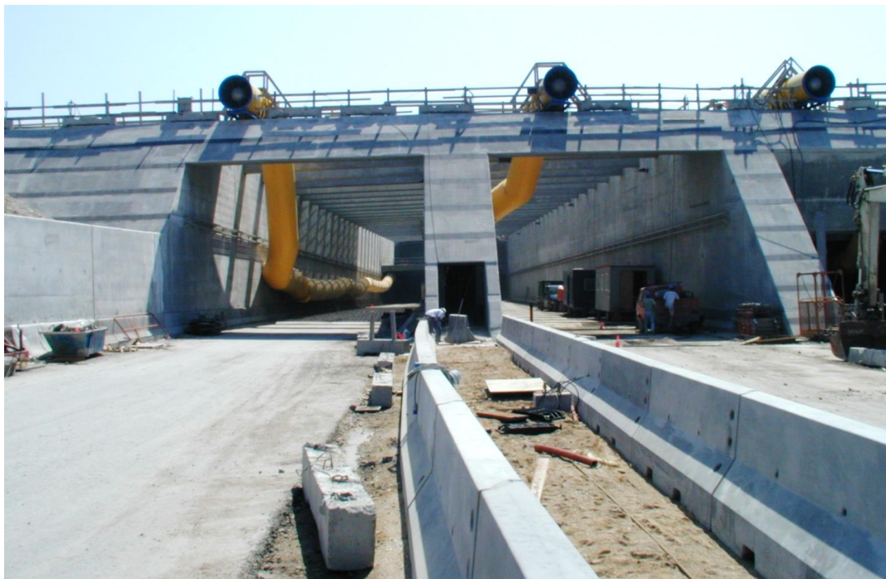
Figur 5. De aktuelle påvirkninger – eksponeringsklasser – for en anlægskonstruktion skal gennemtænkes nøje. Betonautoværnet, støttemurene, det overliggende galleri og selve sænketunnelelementerne er udsat for forskellige påvirkninger, der skal afspejles i kravene til betonen. Levetidskravet på Øresund var sat til 120 år. Billedet er fra nedkørslen til Øresundstunnelen på Amager (indviet år 2000).
