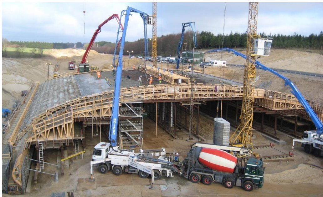
Figur 10. Broer – her en faunapassage – udføres efter AAB'er. De gælder fx Fundering, Stillads og form, Armering og Beton. AABerne er et udtryk for dels krav om en høj kvalitet og lang levetid, dels krav om anvendelse af positive erfaringer.
