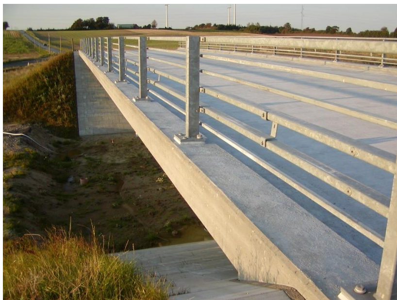
Figur 7. Vejdirektoratet har gennem tiden opført forsøgsbroer med fx mikrosilica, flyveaske og højstyrkebeton. På billedet ses en forsøgsbro ved Tørring udført i 2002 i såkaldt "grøn beton" med reduceret CO 2 -aftryk. Bemærk, at broen er uden fugtisolering og asfalt – der køres direkte på den grønne beton.
