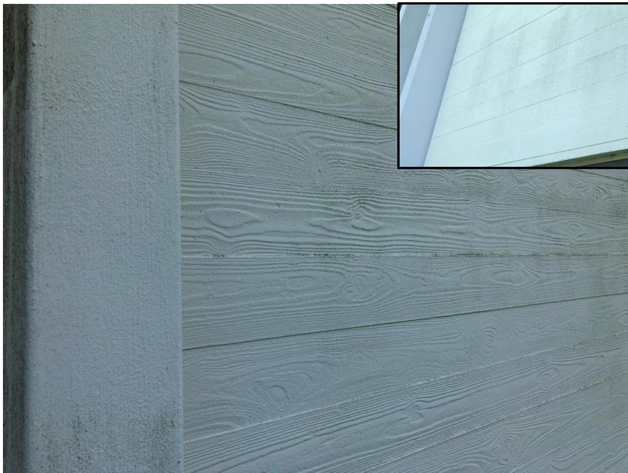
Figur 11. Billedet viser en malebehandlet betonelementoverflade (kulørforskellen er sløret af belysningsforholdene). Malebehandlingen fandt sted 23 år før billedet blev optaget. Malebehandlingen fremstår intakt. Området tv. i billedet blev før malebehandlingen blæserenset ved højtryksspuling med sandtilsats, svummet, malebehandlet med én gang tykfilmsmaling og én gang tyndfilmsmaling. Området th. i billedet blev blæserenset ved højtryksspuling med sandtilsats, malebehandlet med én gang tykfilmsmaling og én gang tyndfilmsmaling. På det indsatte miniaturebillede øverst th., får indtryk af den virkelige kulørforskel – tv. er en kuløren NCS2502-Y mens overfladen th. er NCS1502-Y, svarende til det oprindelige betonelement, hvor den glatte beton var blandet med grå cement, mens den bræddeforskallede beton var blandet med hvid cement.
