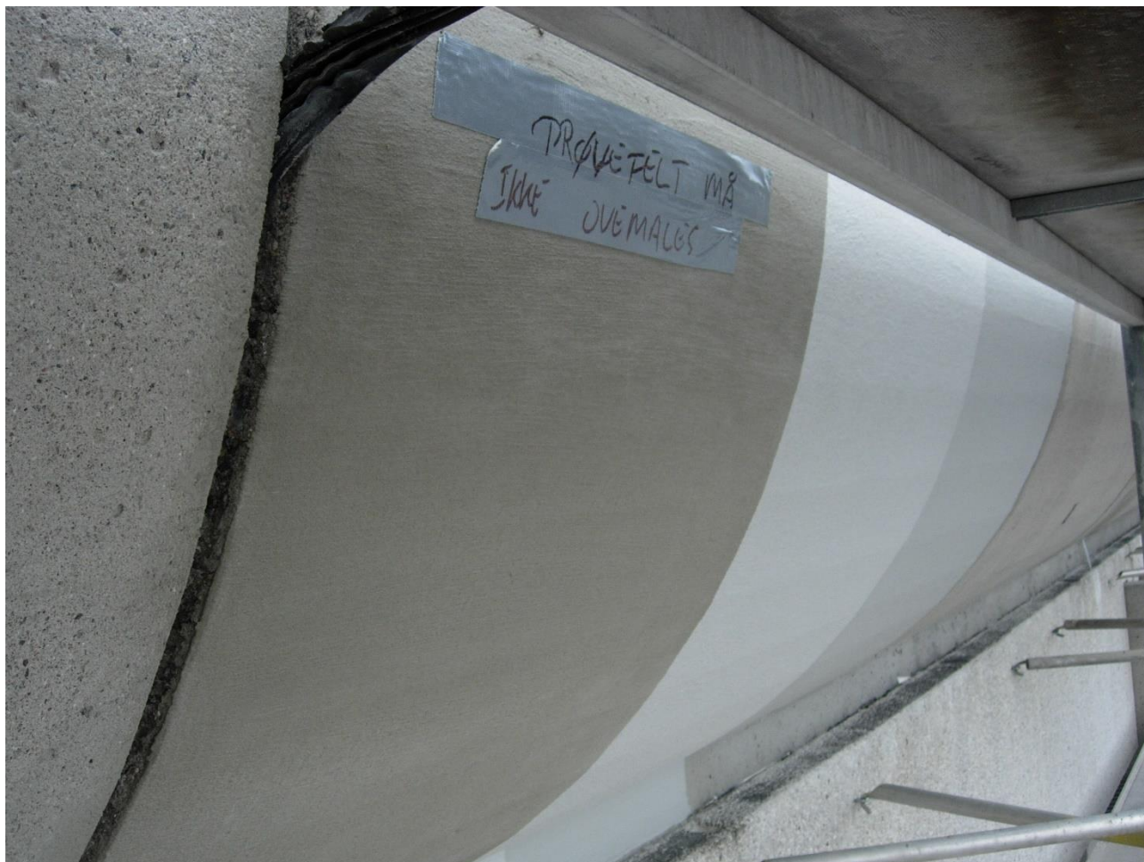
Figur 17. Billedet viser resultatet af en færdigudført prøvebehandling, der viser de forskellige trin i behandlingsopbygningen på en betonoverflade, hvor der efter ca. 40 års brug havde vist sig behov for beskyttelse imod yderligere karbonatisering. Den beskyttende malebehandlings forskellige behandlingstrin ses fra venstre mod højre og består af følgende behandlingstrin: Rensning for fjernelse af betonslamlag og for åbning af porer og revner, svumning af overfladen med en acrylmodificeret svummemørtel for udfyldning af porer og revner og for at opnå en porefri overflade og til sidst påføring af to lag acrylplastmaling – først en hvid og dernæst en grå. På trods af de mange behandlingstrin bliver betonoverfladens spor efter bræddefor-skalling bevaret.
