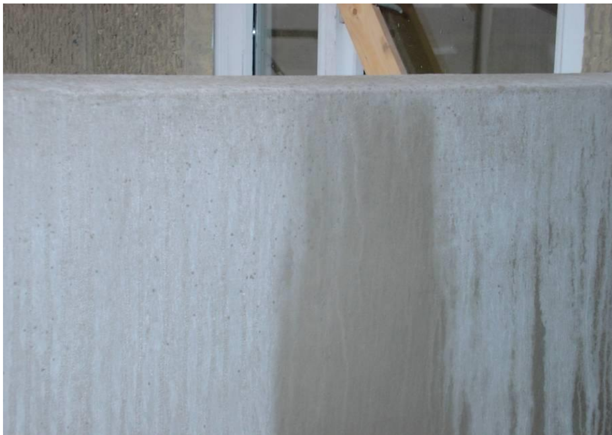
Figur 10. Billedet viser et eksempel på at en flade påført en acrylmodificeret svummørtel har fået hvide udfældninger. Udfældningerne tolkes ofte fejlagtigt som værende acrylen materialet, men laboratorieundersøgelser i mikroskop har fastslået, at der er tale om kalkudfældninger. Se forklaringen i brødteksten.
