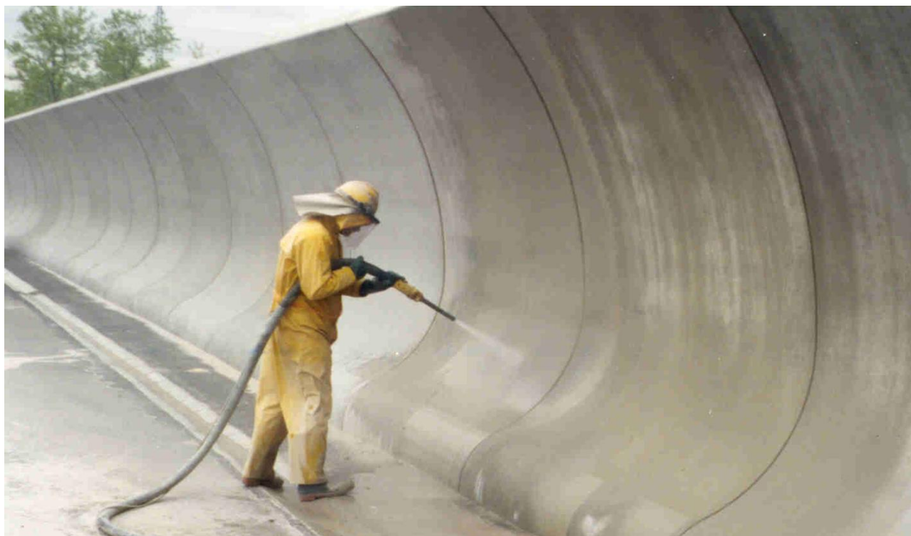
Figur 5. Tunnelelementer støbt i glatte stålforme og opstillet som en ca. 700 m lang støjskærm langs en motorvej, dvs. lige ved siden af nødsporet. Støjskærmen skulle kunstnerisk udsmykkes med en malebehandling, hvorfor bygherren havde en stor interesse i et opnå et holdbart
