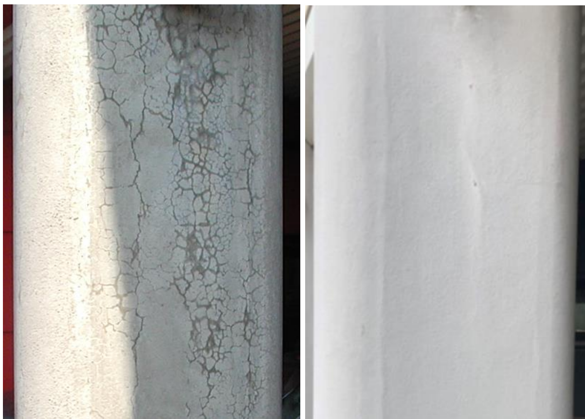
Figur 1. Ved overfladebeskyttelse af betonoverflader kan man forsinke, men næppe helt standse en uønsket udvikling. Billederne viser den samme søjle før behandlingen (tv.) og 16 år efter, at behandlingen blev udført (th.). Betonen er fremstillet omkring år 1986 med lige over 2 % porøs, alkalireaktiv flint i sandfraktionen, og formålet med malebehandlingen var at bremse den forudsete, 'sekundære' nedbrydning af betonen i form af yderligere revnedannelse og yderligere forvitring af betonen. Selv om betonen allerede på tidspunktet for overfladebehandlingen havde mistet en betydelig del af sin trykstyrke, blev det vurderet som værende forsvarligt at "bremse" betonens nedbrydning ved at styre fugtudvekslingen med omgivelserne med en revneoverbyggende behandling med acrylplasttykfilmmaling. Efter 16 år ses tegn på at nedbrydningen ikke er standset, men at udviklingen har været bremset.
