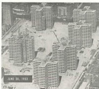
Fig. 17. Efter eneste søjle og bjælke, hvor eneste plade er støbt på stedet. Men pladsen er bejlet af store mobilkrane som kan række ind over øverste dæk i de 14 etagers høje. Den traditionelle opbyggede konstruktion er det på denne måde lykkedes at få i vejret på forsvarende kort tid. Hurtigere kunne det næppe gøres med selv det mest udpejlede elementbyggeri.
