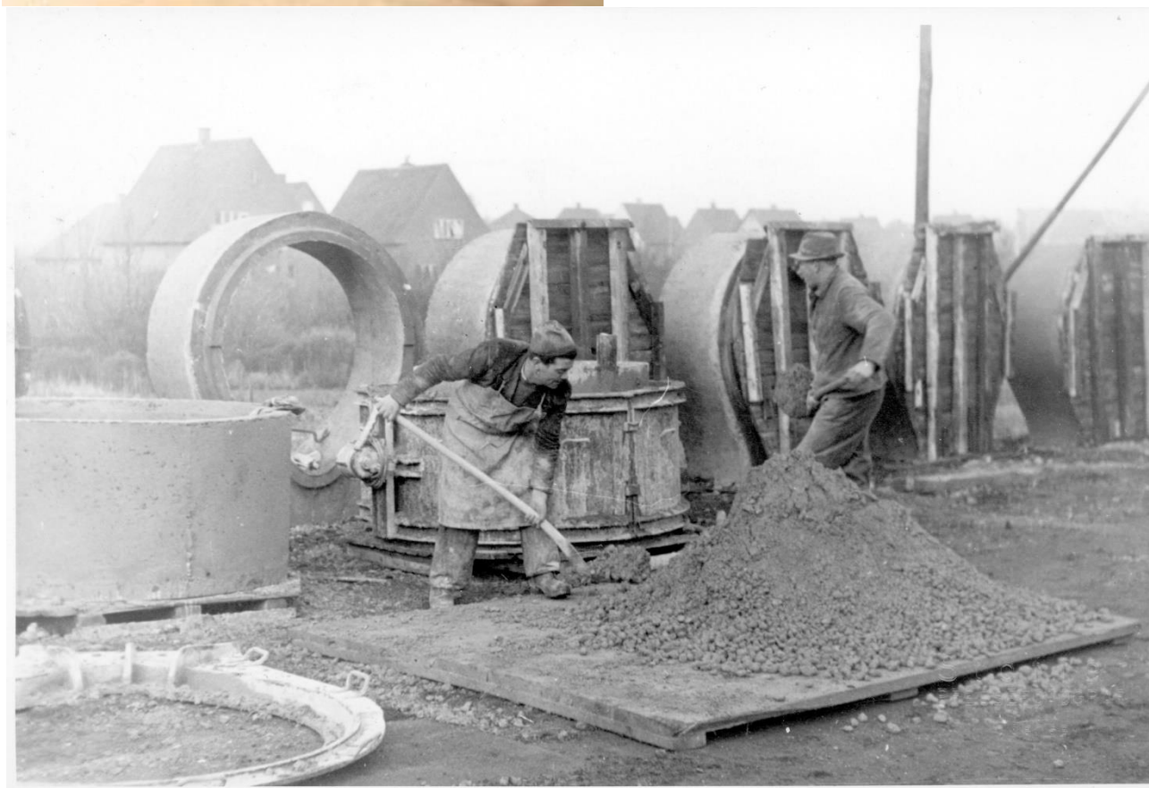
Figur 11. Helt tilbage fra betonens barndom har begrebsbrugen været lidt forvirrende, når man snakker om beton, mørtel og cement. Mange betonvarer er nemlig slet ikke ud fra den moderne betonteknologiske forståelse lavet af beton, men af cementmørtel uden sten i tilslaget. Det gælder fx betonrør som dem på fotografiet. Fotografiet er fra Odense i 1947. Foto: Eduard Christoffersen / Odense Stadsarkiv.
