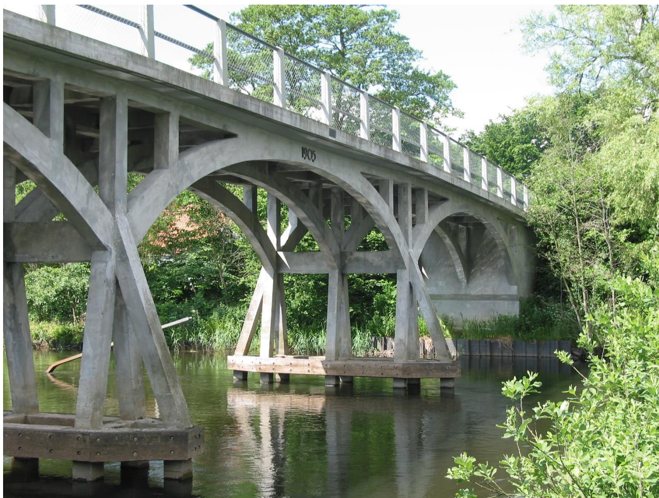
Figur 1. I 1905 stod Christiani & Nielsen bag Amtmand Hoppes Bro over Gudenåen i Langå. Ligesom andre tidlige jernbetonarbejder var forbilledet tømmerkonstruktioner. Samme år fik firmaet overdraget projekteringen af en 40 meter lang anlægsbro ved cementfabrikken Norden. Amtmand Hoppes Bro er fredet og blev restaureret i 1998. Foto: Keld Abrahamsen.
