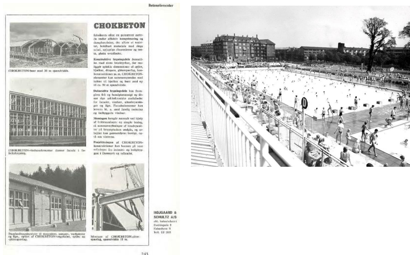
Figur 22. Den hollandske chokbeton, som Højgaard og Schultz fik licens på i 1951, var et fabriksprodukt med høj styrke og tæthed, som gjorde det muligt at minimere konstruktionsdimensionerne. Chokbeton bliver komprimeret ved at lade formen falde ca. 1 cm gentagne gange. Strengbeton, eller for- og efterspændt beton, som den franske ingeniør Eugene Freyssinet havde taget patent på i 1928 og 1939, øgede konstruktionernes spændvidder og mindskede materialeforsbruget. Det blev standard til bærende konstruktionselementer i meget byggeri, blandt andet svømmebassinerne i efterkrigstidens mange nye friluftsbade. Den lette gasbeton, der var nem at håndtere og forarbejde manuelt, blev tilpasset de nye standardmoduler for byggeri og blev ikke mindst populær til det store nye marked for enfamiliehuse. Nedsættelse af konstruktionernes egenvægt i forbindelse med monteringen på arbejdspladsen medvirkede endvidere til anvendelsen af præfabrikerede elementer. Foto til venstre: B.J. Rambøll. (1955). Rationelt byggeri. Foto til højre: COWI STORY.
