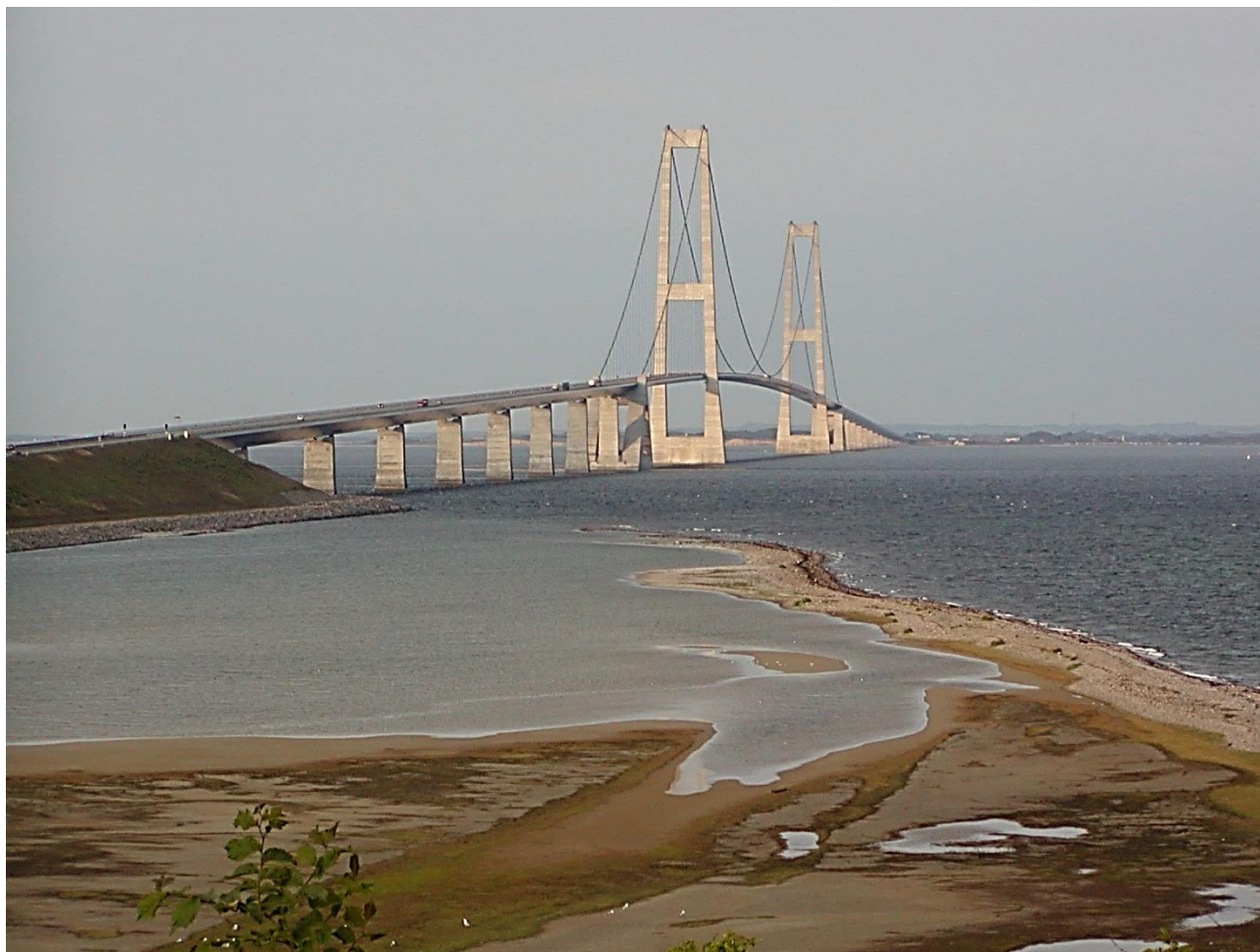
Figur 26. Etorstilet arbejde med udvikling af krav til en beton med lang levetid blev søsat i forbindelse med opførelsen af Storebæltsforbindelsen. Den primære opgave var at udvikle en beton, der var tæt over for indtrængende chlorid. Som beskrevet i betonhåndbogens kapitel 3.5.1 og 3.5.2 blev både flyveaske og mikrosilica krævet anvendt til betonen. Foto: Christian Munch-Petersen.
