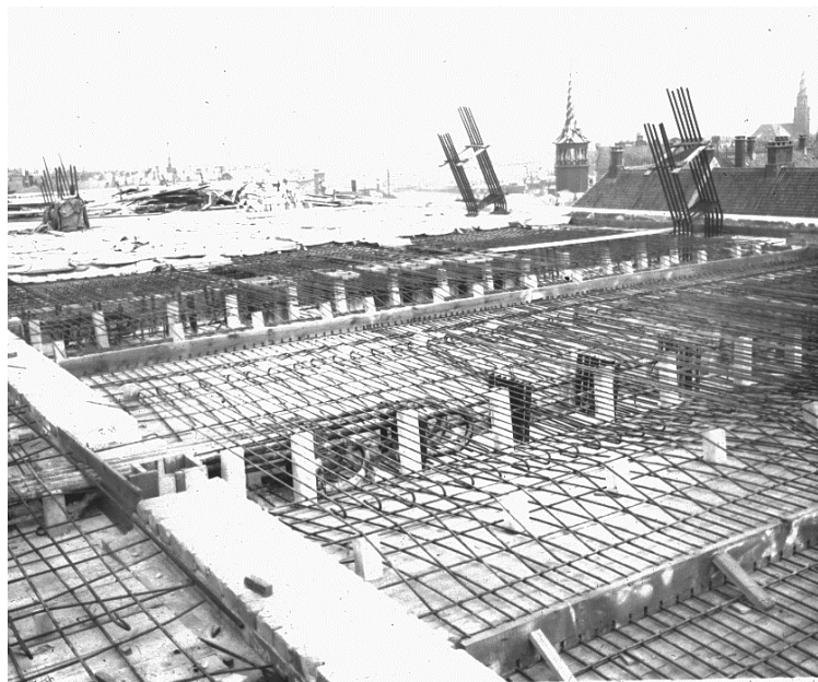
Figur 18. Nogle af de tidligst kendte jernbetonbygninger i Danmark er Christiansborg Slot, der blev bygget fra 1902 -1928, det tidligere musikkonservatorium i København og Statens Museum for Kunst. På fotografiet ses Christiansborg under opførelse. Foto: Teknologihistorie DTU
