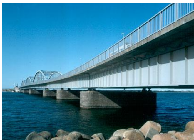
Figur 2: Tv. ses Oddesundbroen, opført i 1938, hvor der gennem tiden er holdt øje med betonens tilstand på både makro- og mikroniveau samt udført reparationer løbende. Foto: Vejdirektoratet. Th. ses udtagelse af borekerne under en buebro.
