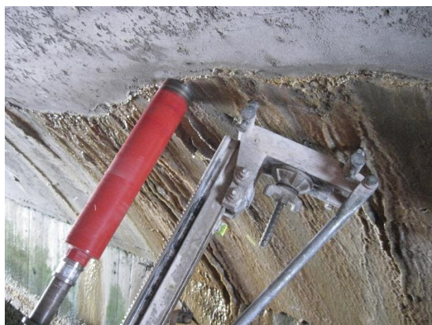
Figur 2: Tv. ses Oddesundbroen, opført i 1938, hvor der gennem tiden er holdt øje med betonens tilstand på både makro- og mikroniveau samt udført reparationer løbende. Foto: Vejdirektoratet. Th. ses udtagelse af borekerne under en buebro.
